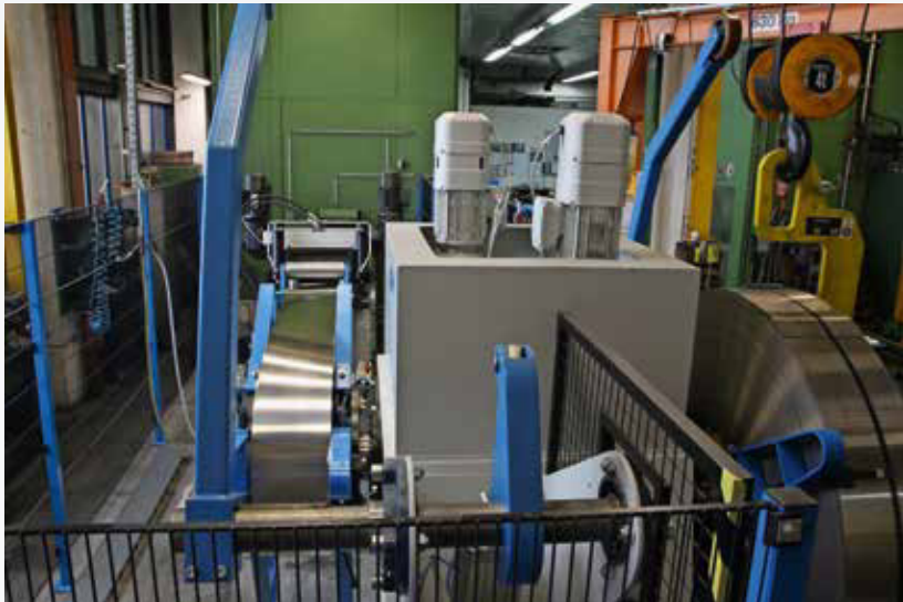
Blick über die Linie: Während rechts beladen wird ist links schon fast wieder das Coil zu Ende.
